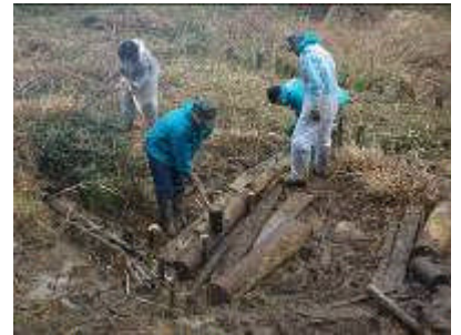
ピオトープ整備 杭打ち
